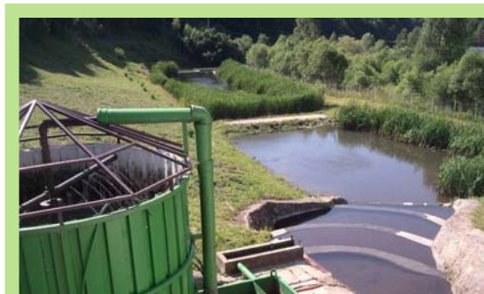
Sistem za prečišćavanje otpadnih voda
